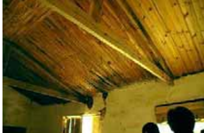
雨漏りのために天井がかなり傷んでいる。
